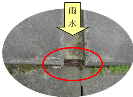
雨樋からの排水先
