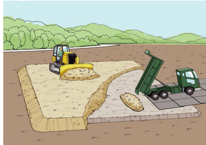
盛土・覆土による造成
