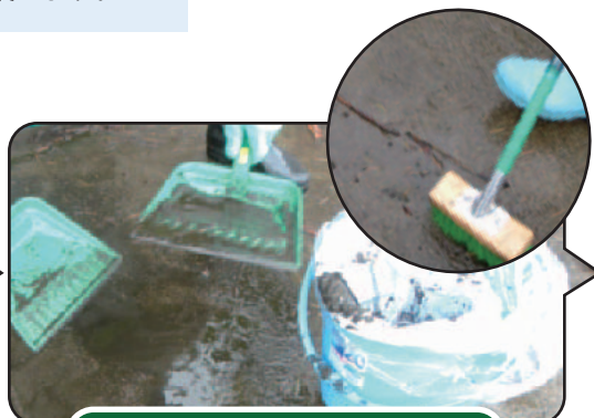
土砂等の除去（外側から内側へ）
