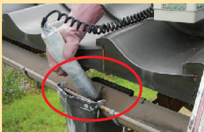
雨樋の集水器
