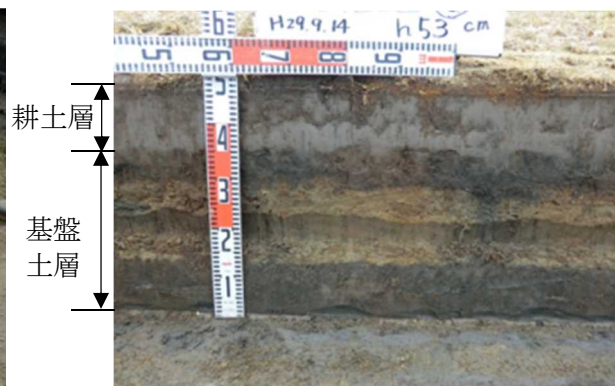
掘削面の状況（水田）
