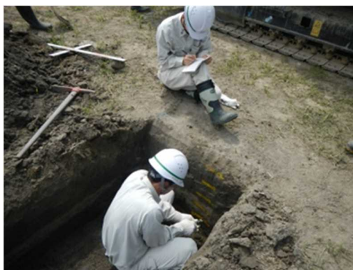
掘削後、目視観察状況
