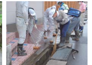
道路脇や側溝の除染の例 (汚泥の除去、タイル目地や側溝隙間のブラシ掛け) 提供：福島市
