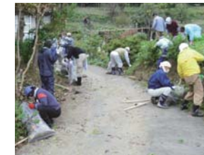
庭などの除染の例 (落ち葉などの除去) 提供：伊達市
