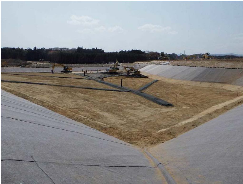
貯蔵区画の全景
