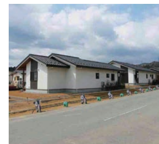
建設が進む公営復興住宅
