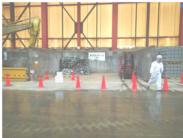
軟化処理設備設置箇所
