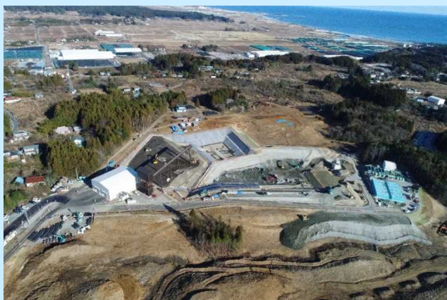
双葉 2 期①工区土壌貯蔵施設（2018. 12. 25撮影） 2018年12月の貯蔵量：約0.6万 \text{m}^3 （累計約2.5万 \text{m}^3 ）
