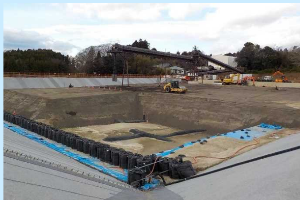
双葉 1 期①工区土壌貯蔵施設（2018. 12撮影） 2018年12月の貯蔵量：約0.6万 \text{m}^3 （累計約1.5万 \text{m}^3 ）
