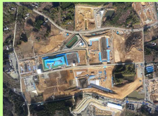
大熊 1 期②工区及び 2 期②工区土壌貯蔵施設 （2018. 12. 5撮影） 2018年12月の貯蔵量（第 1 期施設/第 2 期施設） ：約1.0万 \text{m}^3 /約2.1万 \text{m}^3 （累計約9.0万 \text{m}^3 /約6.3万 \text{m}^3 ）
