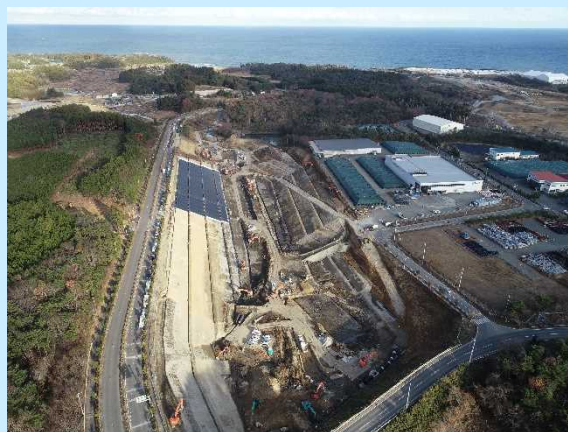
双葉 2 期②工区土壌貯蔵施設（2018. 12撮影） 建設中
