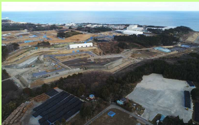
大熊 2 期③工区土壌貯蔵施設（2018. 12. 24撮影） 2018年12月の貯蔵量：約1.1万 \text{m}^3 （累計約1.7万 \text{m}^3 ）
