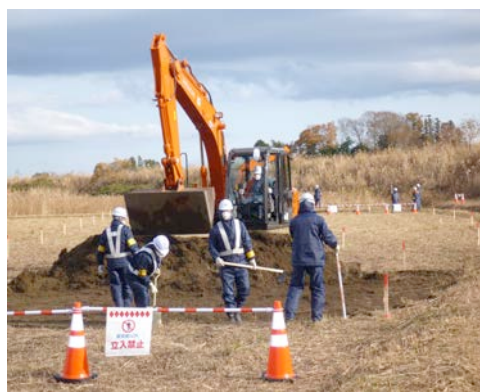
仮置場の表土剥ぎ取り作業
