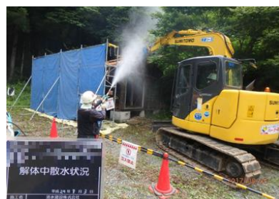
被災家屋等の解体の様子
