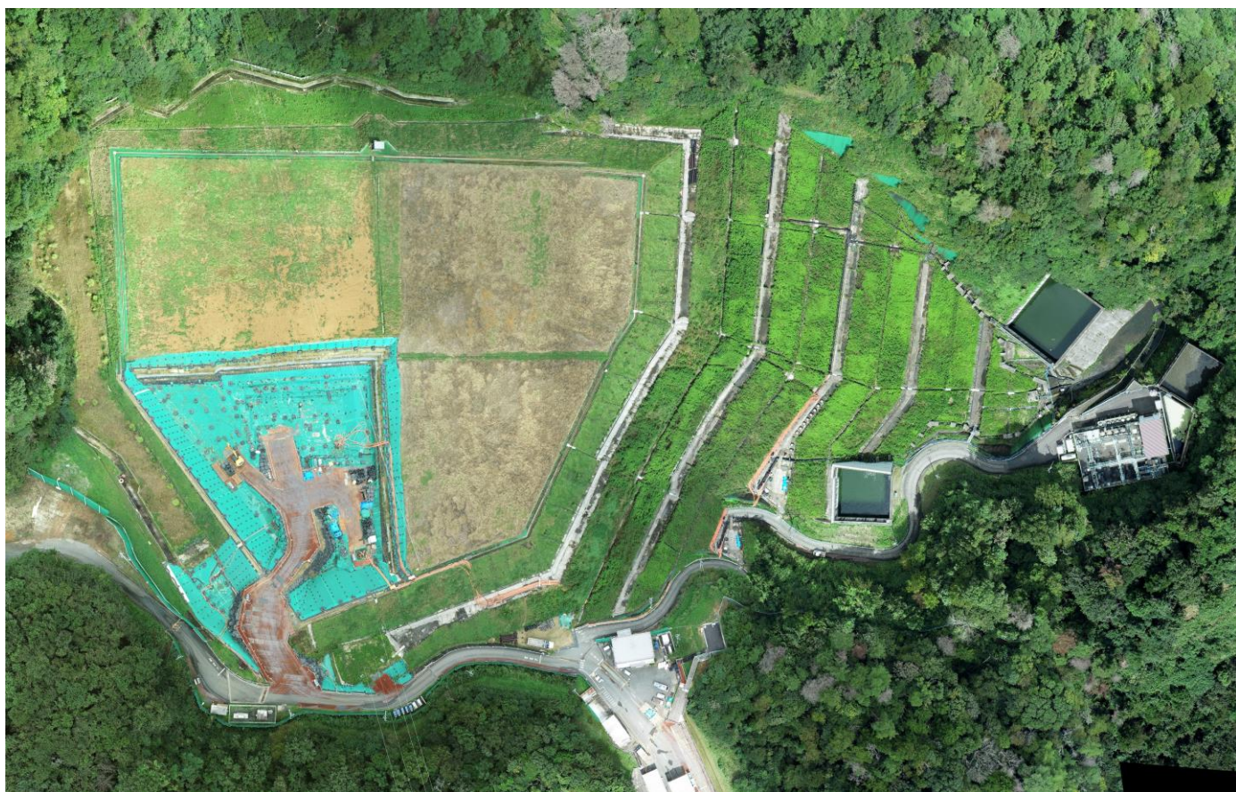
特定廃棄物埋立処分施設 （2026年9月17日撮影）
