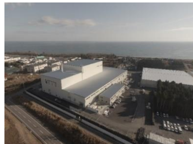
大熊町の仮設焼却施設
