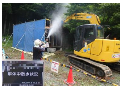
被災家屋等の解体の様子
