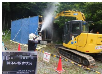
被災家屋等の解体の様子
