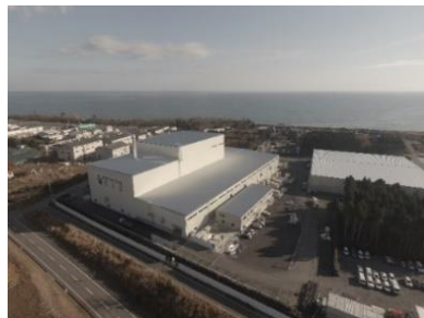
大熊町の仮設焼却施設
