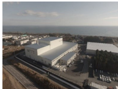
大熊町の仮設焼却施設
