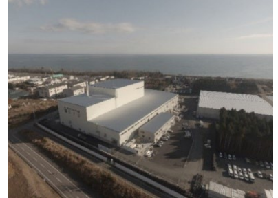
大熊町の仮設焼却施設
