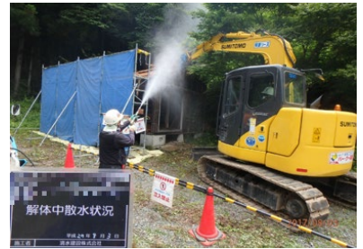
被災家屋等の解体の様子
