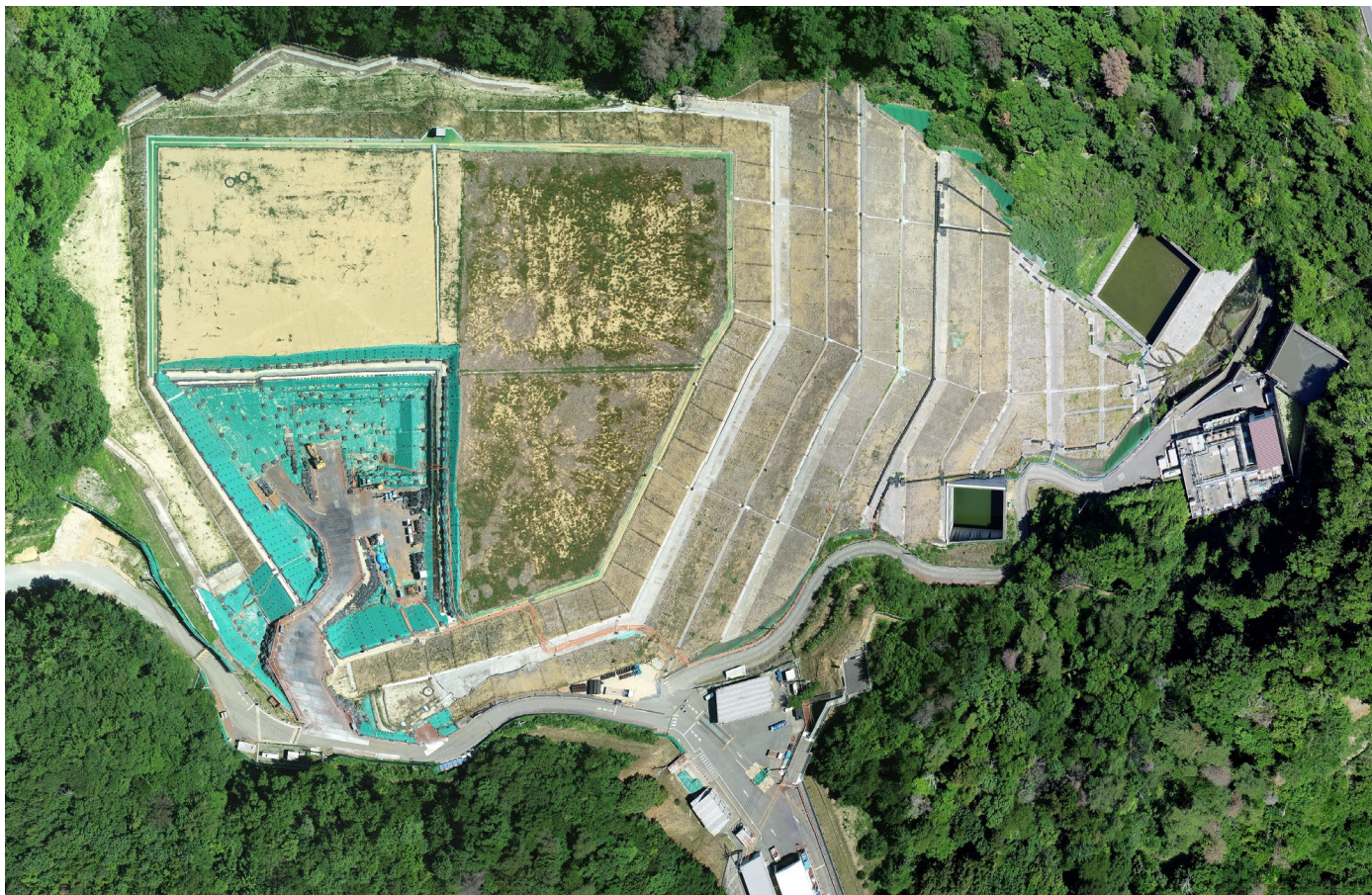
特定廃棄物埋立処分施設 （2026年6月1日撮影）
