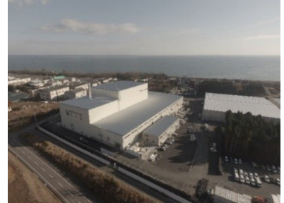
大熊町の仮設焼却施設
