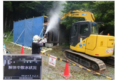
被災家屋等の解体の様子
