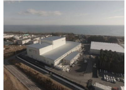
大熊町の仮設焼却施設
