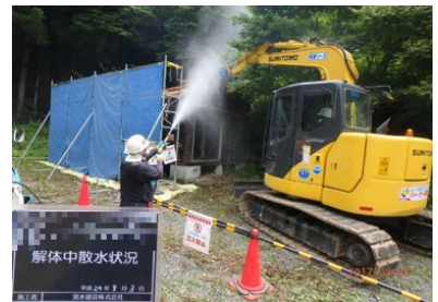
被災家屋等の解体の様子
