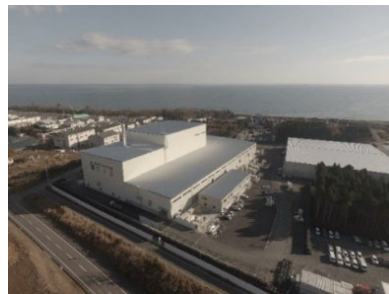
大熊町の仮設焼却施設
