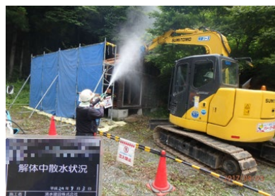
被災家屋等の解体の様子
