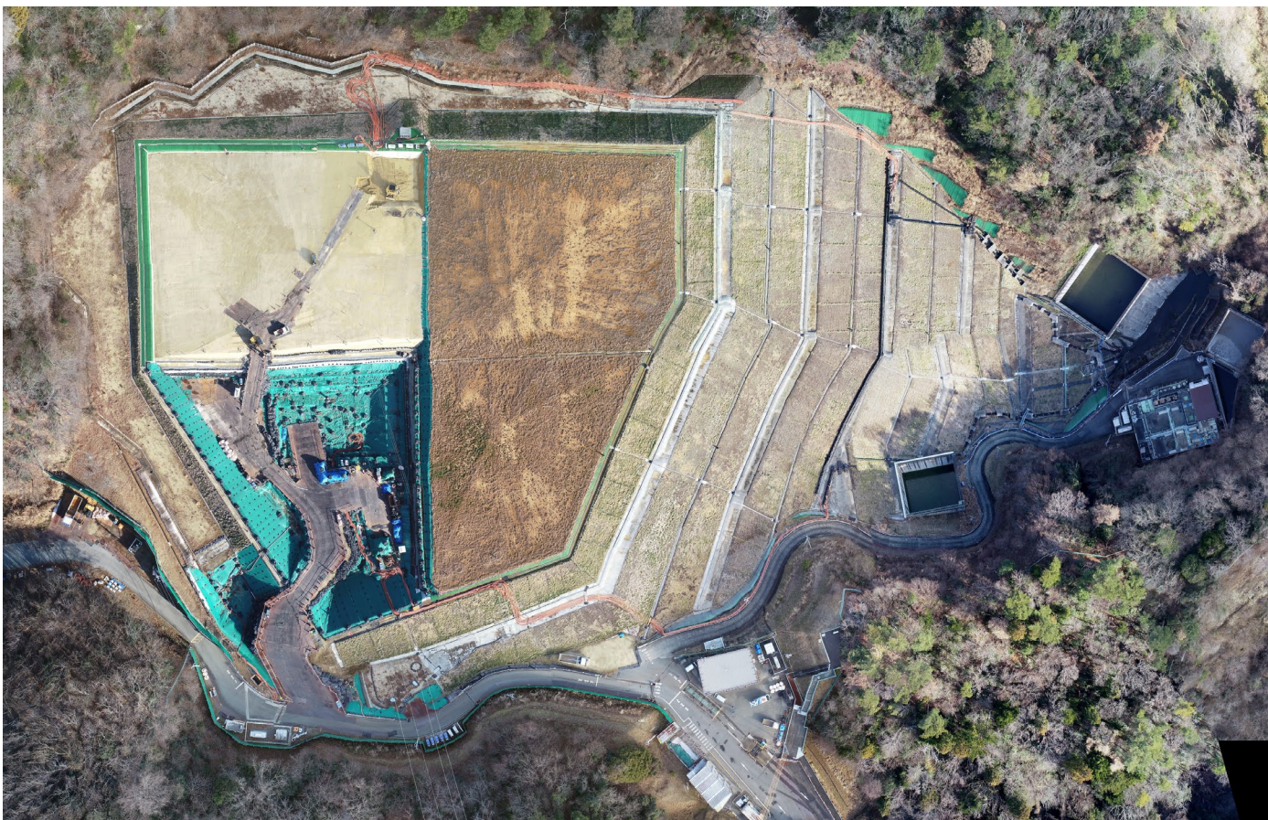
特定廃棄物埋立処分施設 （2026年1月6日撮影）
