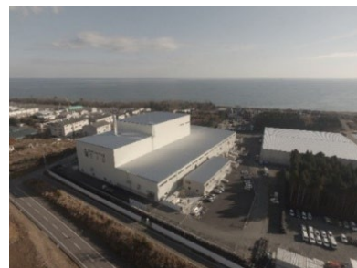
大熊町の仮設焼却施設
