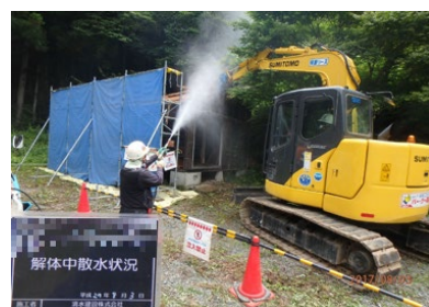
被災家屋等の解体の様子
