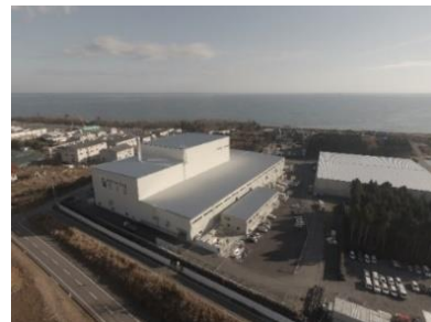
大熊町の仮設焼却施設
