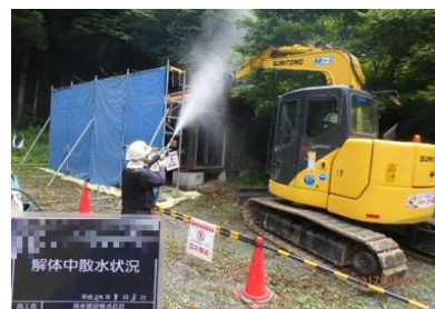
被災家屋等の解体の様子
