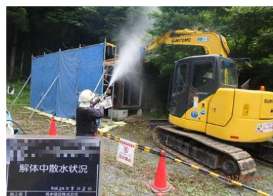
被災家屋等の解体の様子
