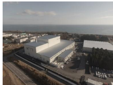
大熊町の仮設焼却施設
