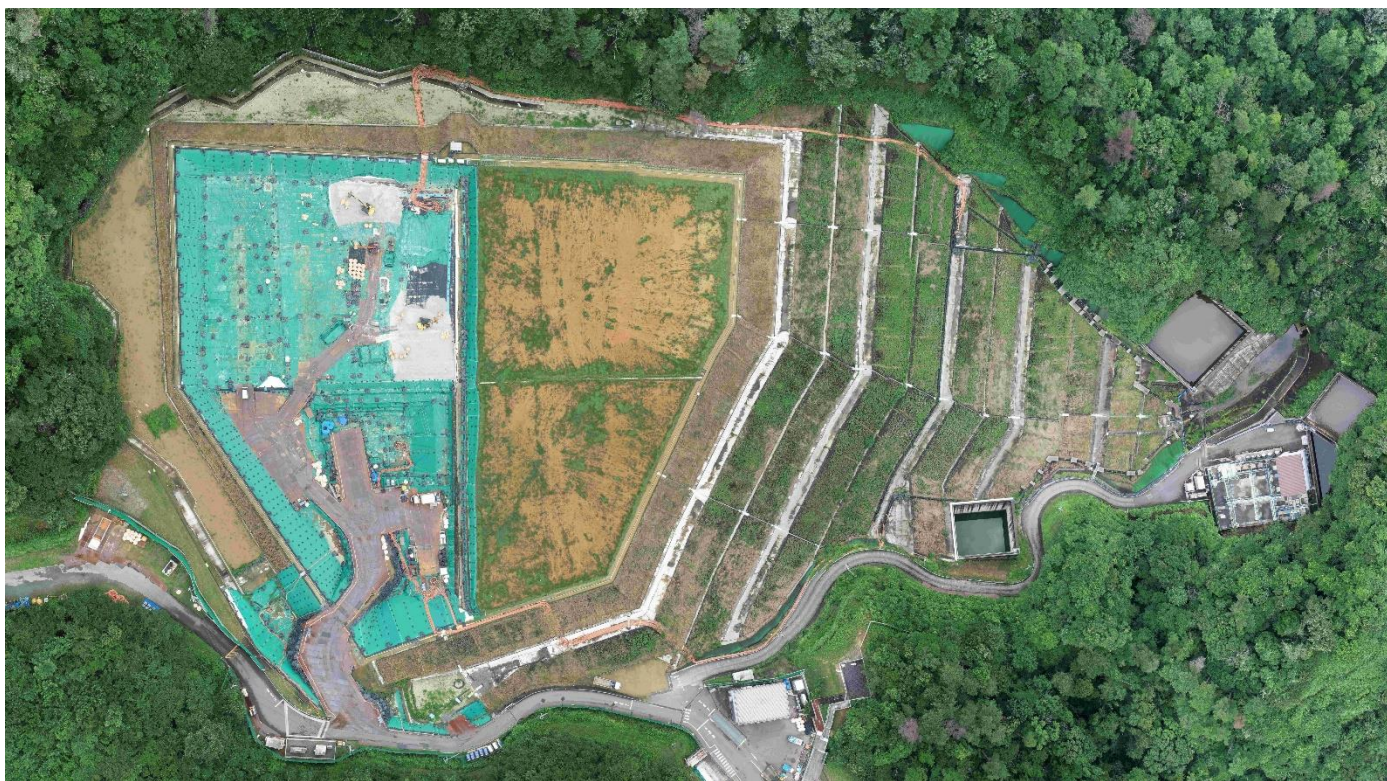
特定廃棄物埋立処分施設（2025年7月16日撮影）
