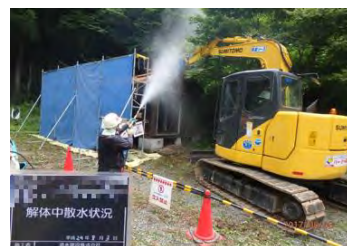
被災家屋等の解体の様子
