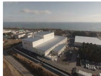
大熊町の仮設焼却施設
