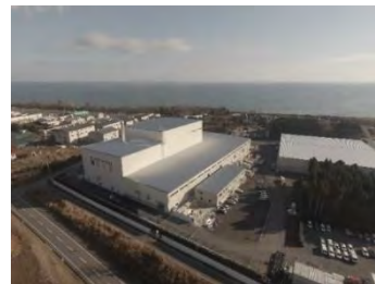
大熊町の仮設焼却施設
