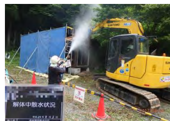
被災家屋等の解体の様子
