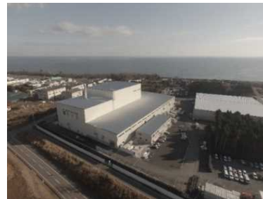
大熊町の仮設焼却施設
