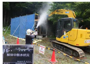
被災家屋等の解体の様子
