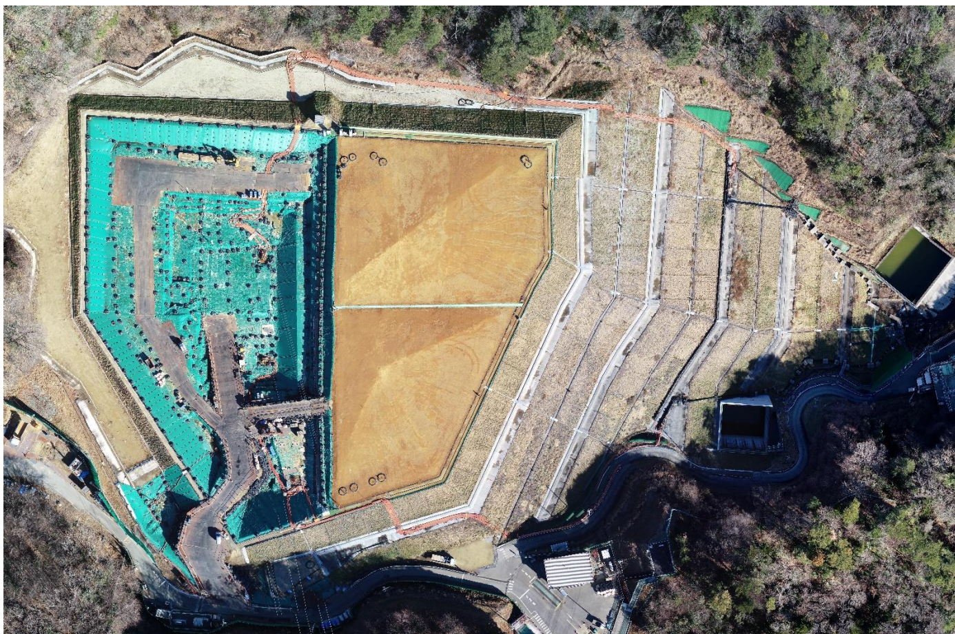
特定廃棄物埋立処分施設（2025年1月14日撮影）
