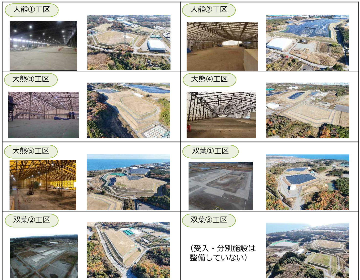
左の写真が受入・分別施設、右の写真が土壌貯蔵施設
