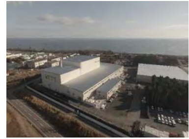
大熊町の仮設焼却施設
