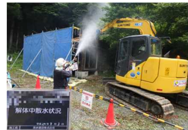
被災家屋等の解体の様子
