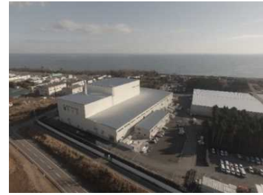
大熊町の仮設焼却施設
