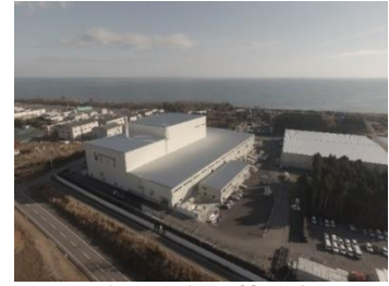
大熊町の仮設焼却施設
