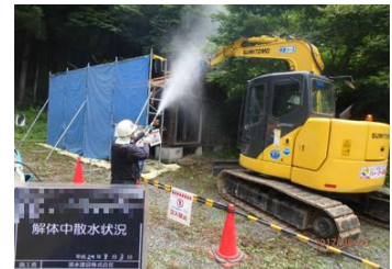
被災家屋等の解体の様子
