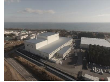
大熊町の仮設焼却施設
