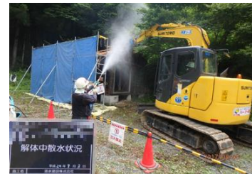
被災家屋等の解体の様子
