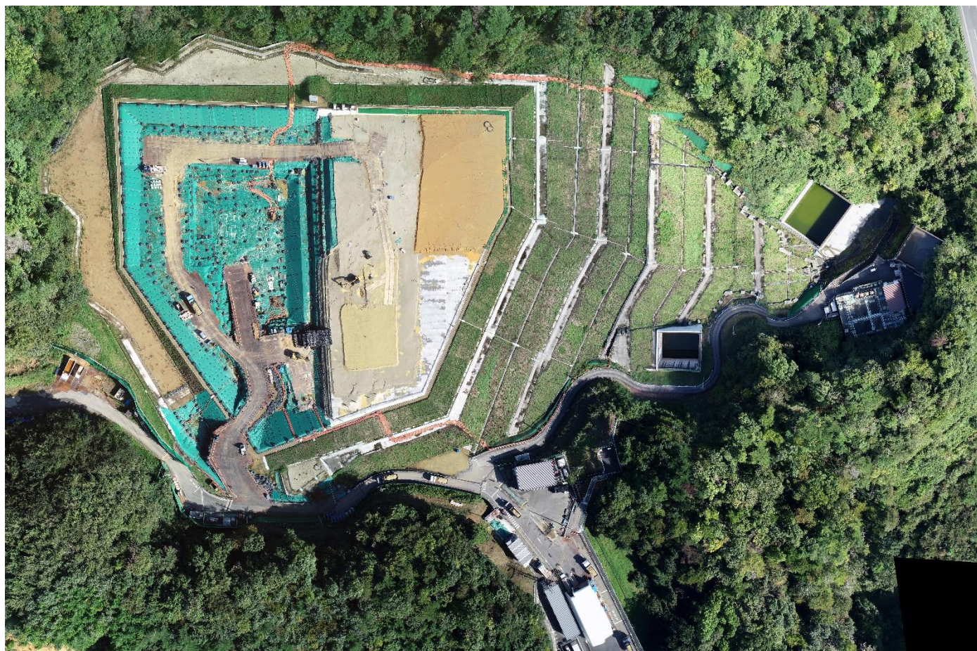
特定廃棄物埋立処分施設（2024年10月11日撮影）
