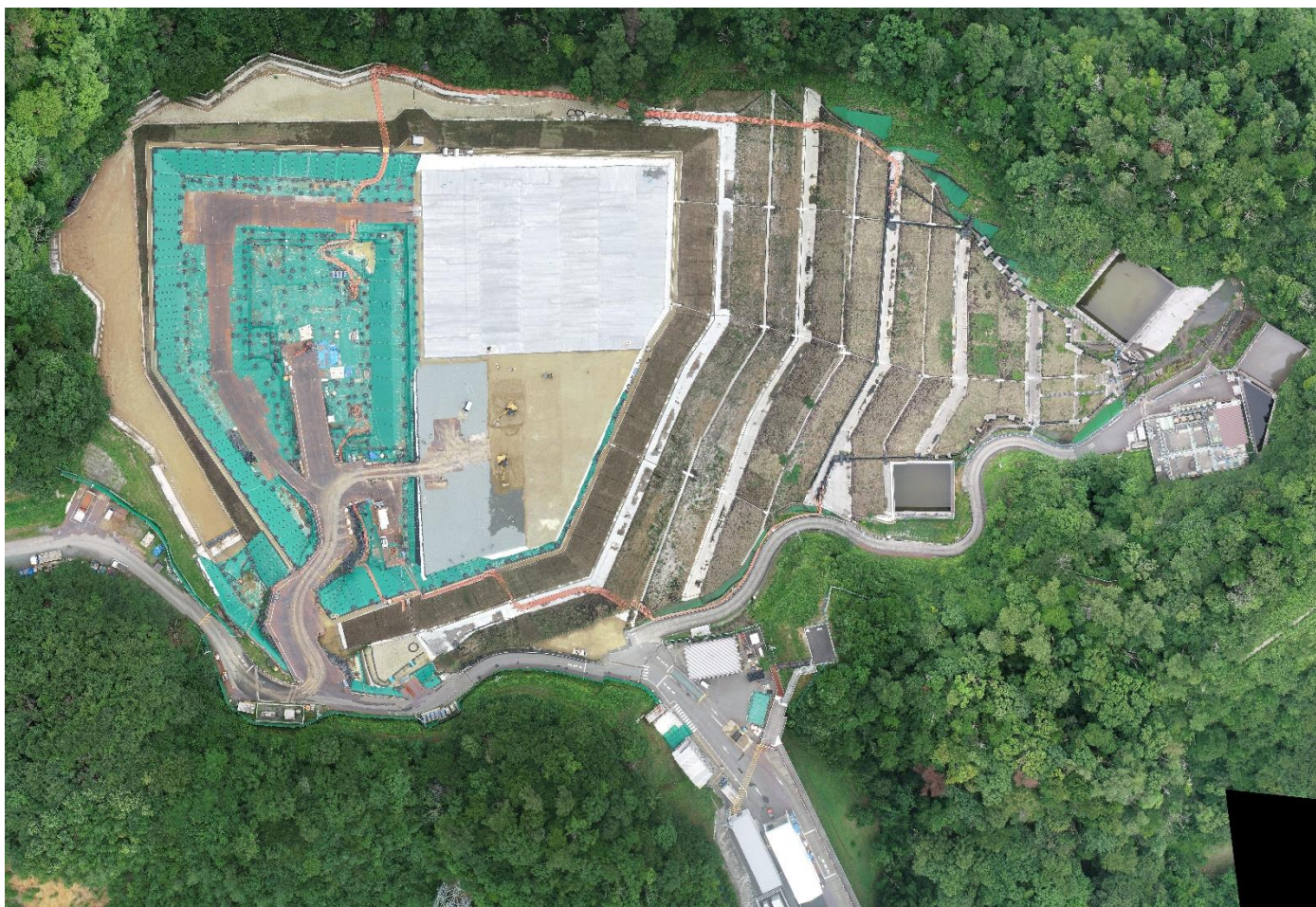
特定廃棄物埋立処分施設（2024年7月16日撮影）
