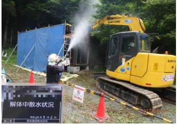
被災家屋等の解体の様子
