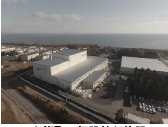
大熊町の仮設焼却施設
