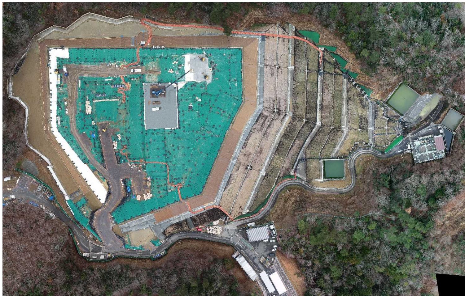
特定廃棄物埋立処分施設（2024年1月22日撮影）
