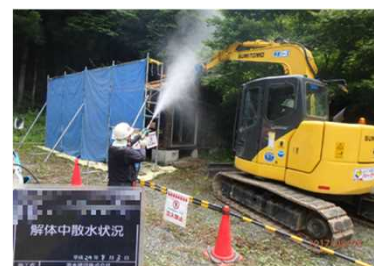
被災家屋等の解体の様子
