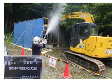
被災家屋等の解体の様子
