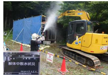
被災家屋等の解体の様子
