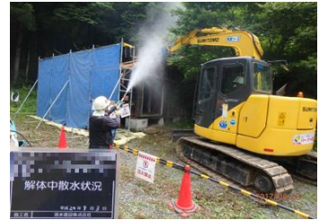
被災家屋等の解体の様子
