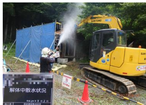
被災家屋等の解体の様子
