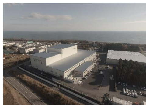
大熊町の仮設焼却施設
