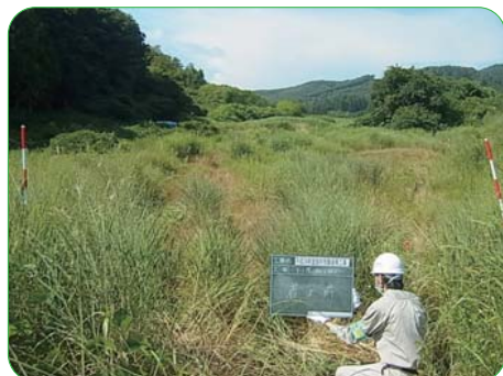
① 設置する場所を除染し、整地します。
