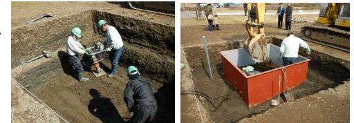
試験施工の様子
