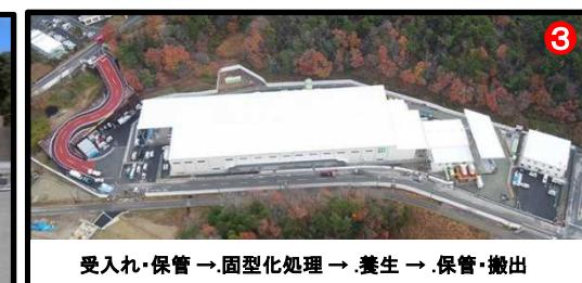
受け入れ・保管 → 固型化処理 → 養生 → 保管・搬出
