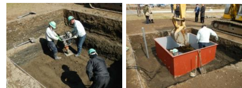
試験施工の様子
