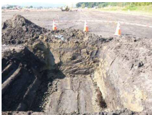
浸出水集水設備撤去後
