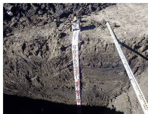
掘削壁面接写
