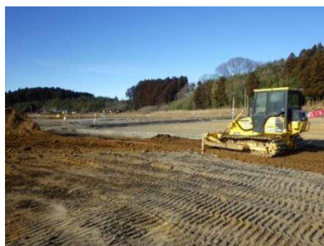
客土施工状況
