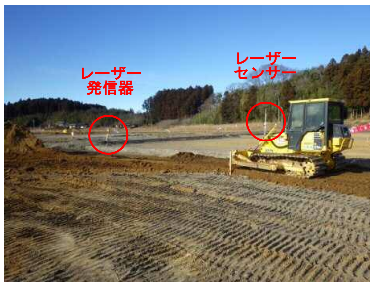
ブルドーザ整地
