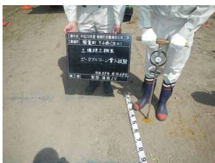
ポータブルコーン貫入試験状況
