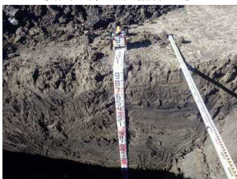
掘削壁面調査状況
