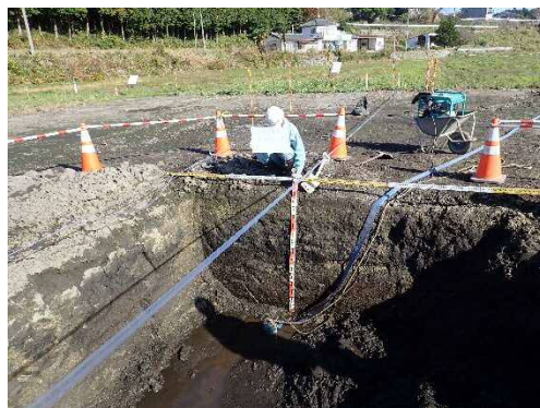
浸出水集水設備掘削壁面状況
