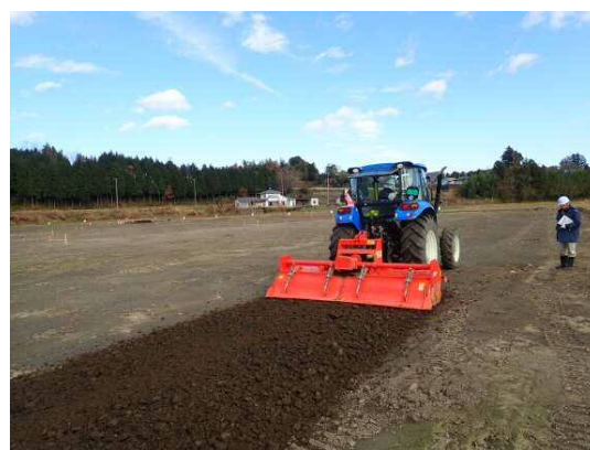
ロータリーによる砕土
