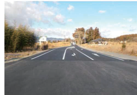
舗装厚改良工事後の道路の様子(県道251号)
