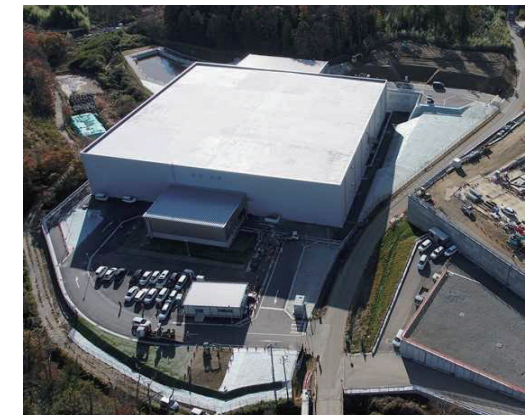
廃棄物貯蔵施設(双葉1工区)
