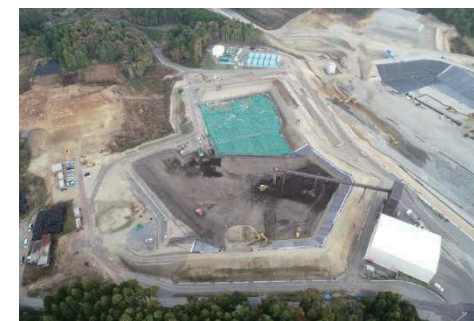
土壌貯蔵施設(双葉①工区)
