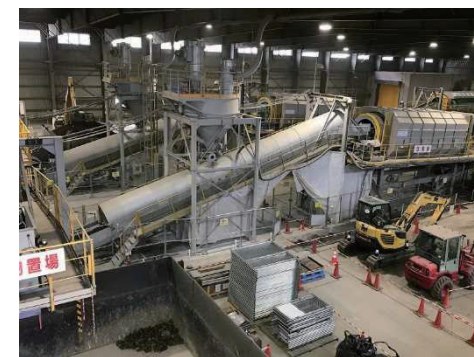
受入・分別施設(大熊①工区)
