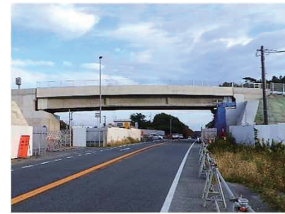
②新設橋梁(名称:中央台こ道橋)
