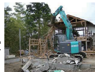
被災家屋等の解体
