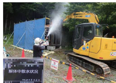
被災家屋等の解体の様子
