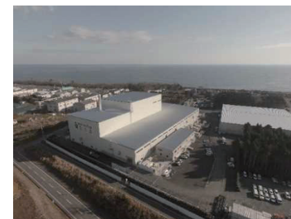
大熊町の仮設焼却施設
