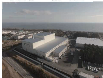
大熊町の仮設焼却施設
