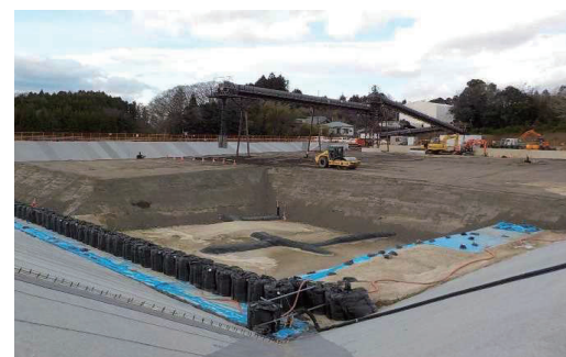
土壌貯蔵施設(双葉1期①工区)
