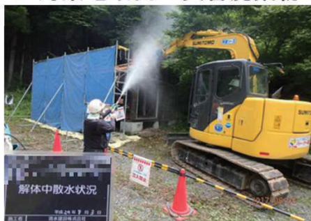
被災家屋等の解体の様子
