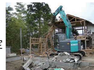
被災家屋等の解体
