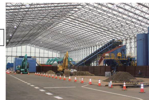
受入・分別施設(大熊1期②工区)
