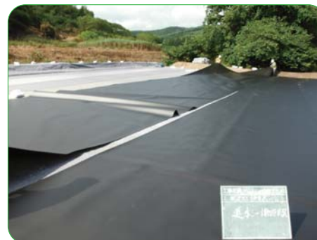
③ 防水シートなどを敷きます。
