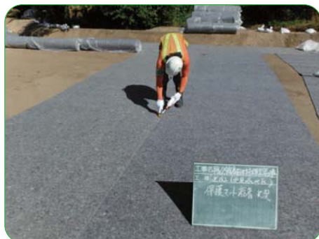
② 必要に応じて保護マットを敷きます。
