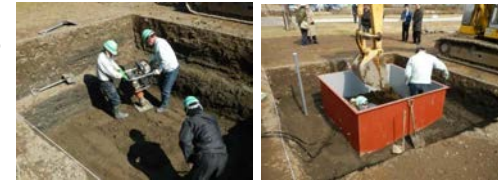
試験施工の様子
